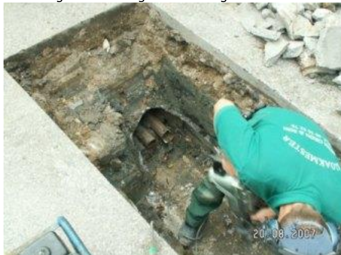
Fjernelse af gammel fjernvarmeledning
