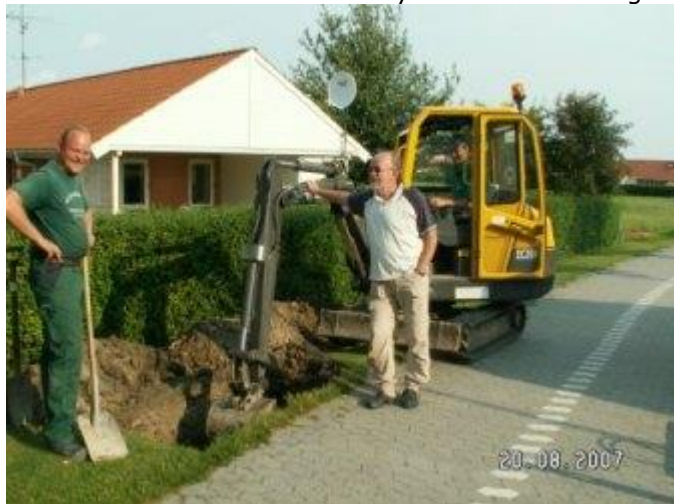
Opgravning til "borehul"
